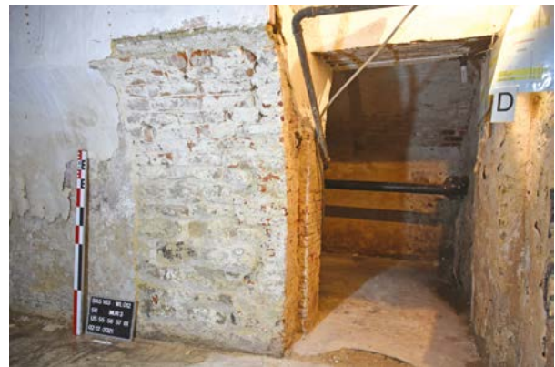
Fig. 1 Vue du mur support de voûte en moellons de calcaire gréseux et départ de voûte en briques dans le logis du meunier de Lindekemale à Woluwe-Saint-Lambert (bâtiment nord), secteur 8. (photo S. Byl © urban.brussels-ULB).
