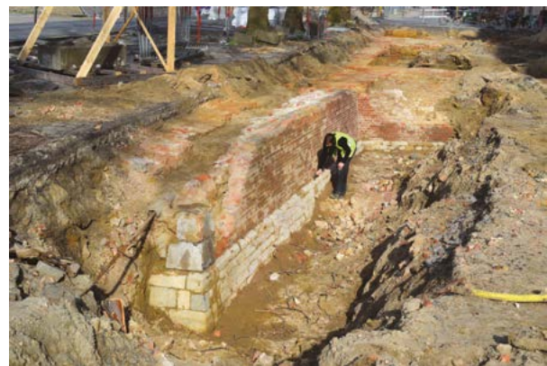
Fig. 3 Het onderzoek op de resten van bastion Duc van de 16de-eeuwse citadel bij rioleringswerken aan de Gedempte Zuiderdokken. De hoek tussen de hoge en teruggetrokken lage flank werd versterkt met blauwe hardsteen. (© Stad Antwerpen dienst archeologie).
