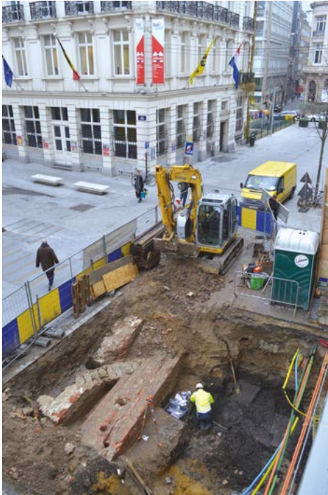
Fig. 1 Vue de la fouille de la rue Léopold (photo S. Modrie © urban.brussels-ULB).
