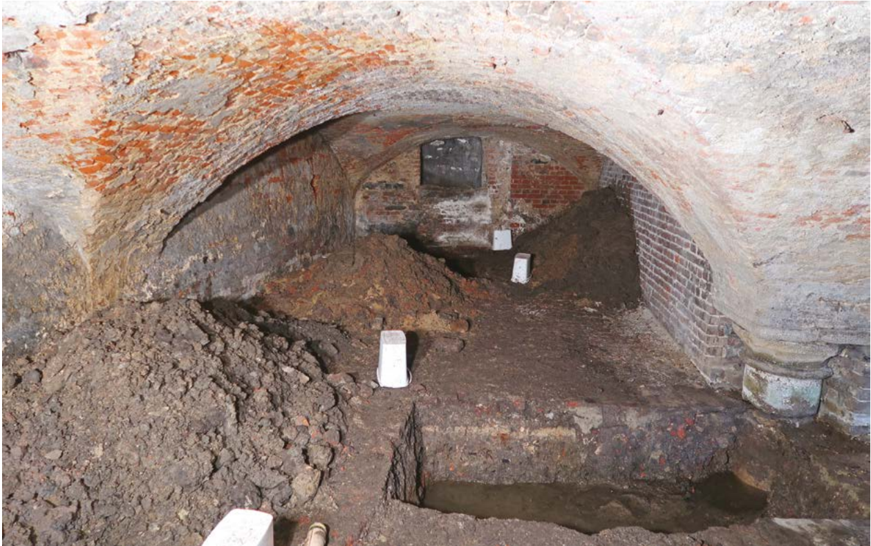
Fig. 1 Algemeen gezicht op de oostelijke travee van de kelderruimte (© Stad Gent, De Zwarte Doos, Stadsarcheologie).
