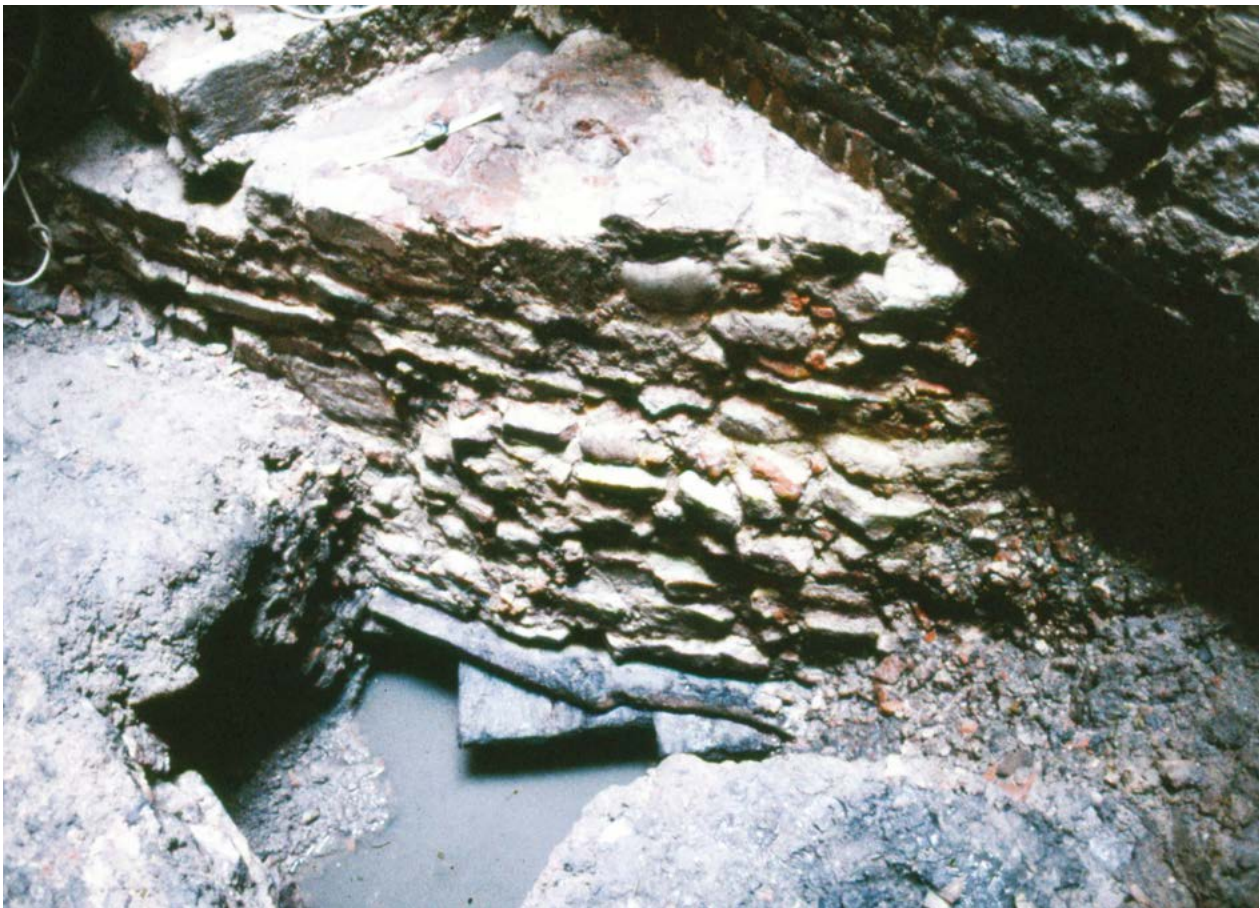
Fig. 3 Bruxelles, place Saint-Géry, n° 33. Maçonnerie en fondation reposant sur un radier de bois (© SRAB).
