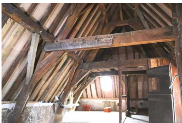
Fig. 1 Vue générale du comble à surcroît (photo S. Cremer © urban.brussels-IRPA).
