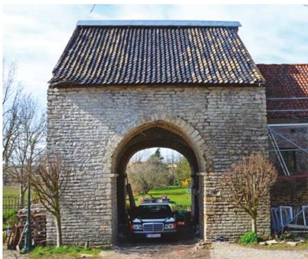
Fig. 1 Façade est de la tour-porche (© urban.brussels – CReA-P).
